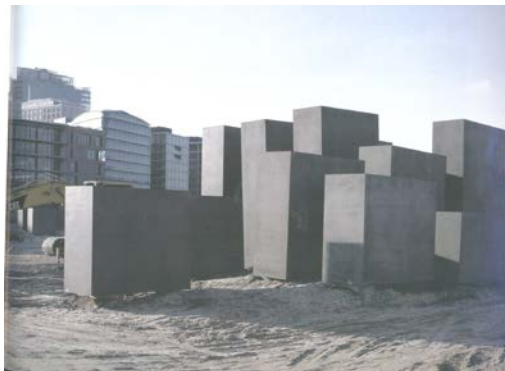
στη διάρκεια της κατασκευής
